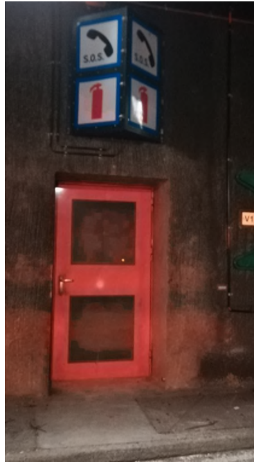
Figure 18: Nouvelle niche de sécurité fermée par une porte
