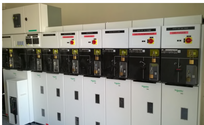
Figure 23: Poste de livraison « Aération » rénové
