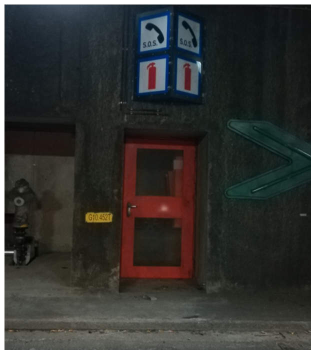
Figure 20: Nouvelles niches incendie et sécurité séparées
