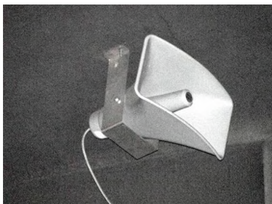
Figure 56: Sirène en tunnel
