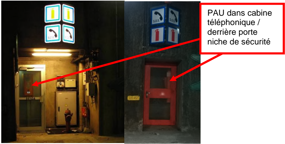
Figure 46: PAU en tunnel et signalétique
