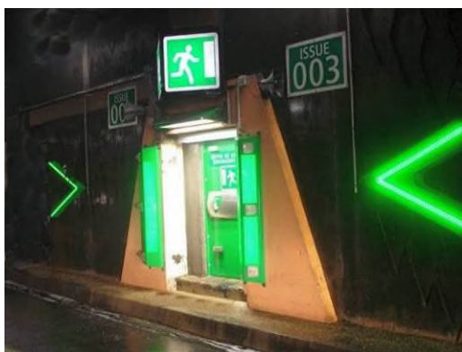
Figure 55: Eclairage des issues en mode évacuation
