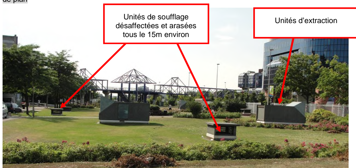
Figure 32: Exemple d'unités de soufflage et d'unité d'extraction
